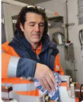
Roberto Evangelisti, AEW Netzelektriker, reinigt den Leistungsschalter in der Trafostation Dottikon
